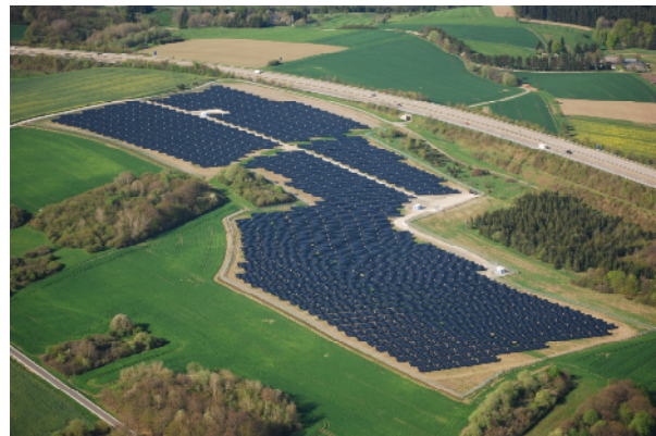
Vergleichbare Anlage (3,5 MW) bei Trier (Solarpark „Mehringer Höhe“)
