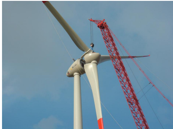
Montage des Rotors im Spätsommer 2006
